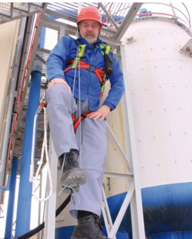
Entlastung durch Stemmen eines Fußes in eine Trittschlinge
