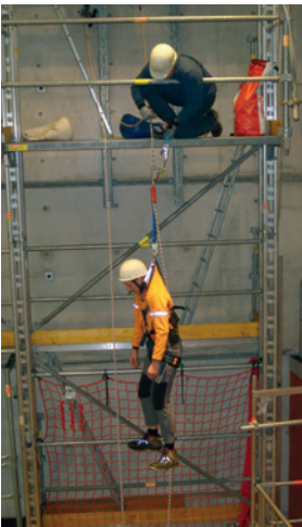
Rettung einer frei hängenden Person mit Abseilgerät mit Rettungshubeinrichtung
